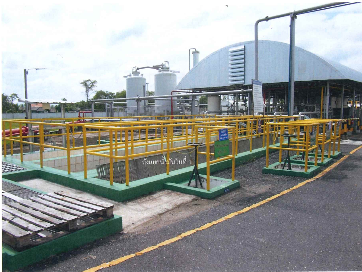
รูปถ่ายที่ 1 ถังแยกน้ำมันใบที่ 1 แบบ CPI ที่อยู่ภายในคั่งน้ำมันเซลล์บ้านดอน สุราษฎร์ธานี
